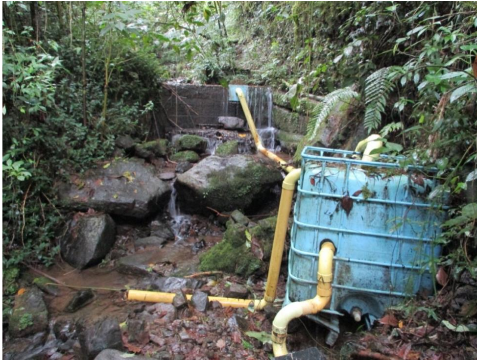
Zone de captage d'eau de l'aqueduc Manga Arriba, département de Girardota, 2018 (source: Brendan Ecuyer)
