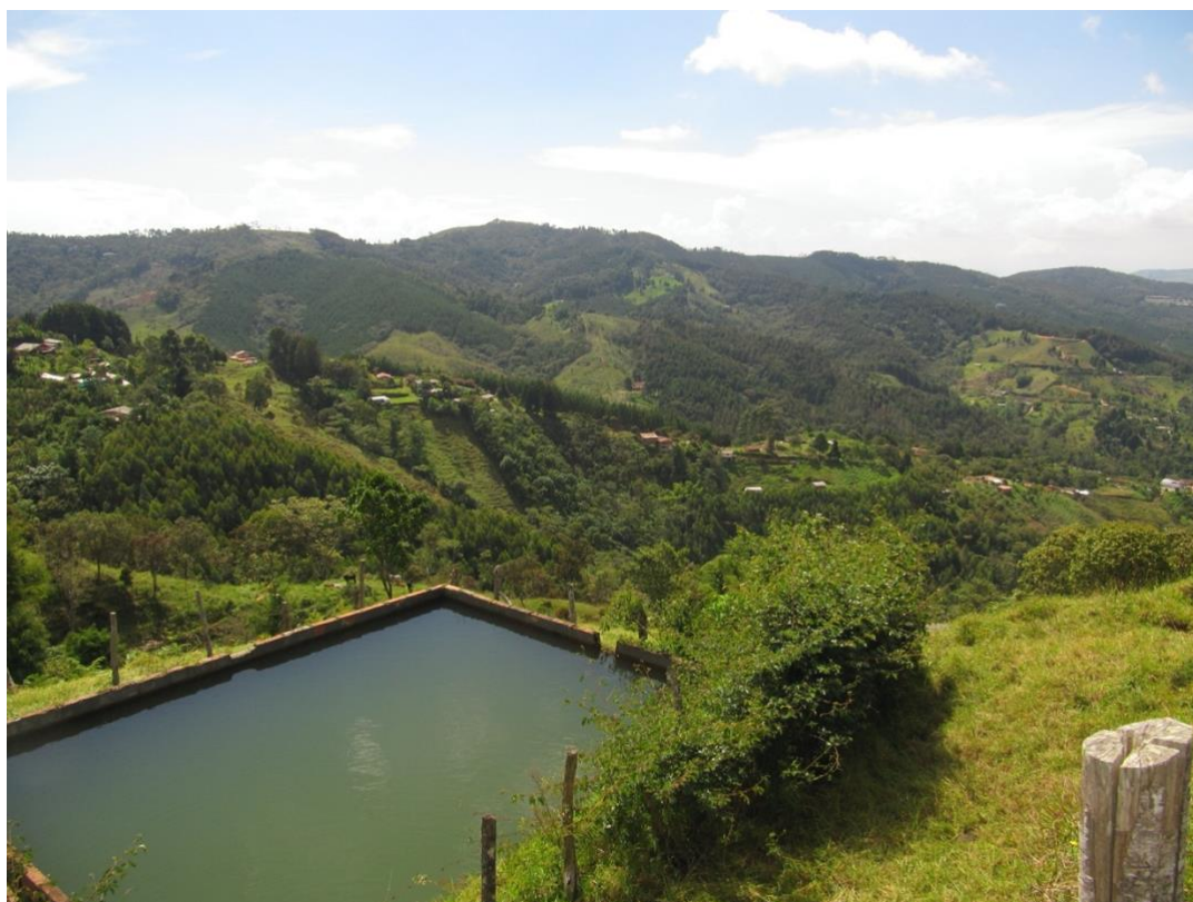
Réservoir d'eau, municipalité de Caldas, département d'Antioquia, 2014 (source: Brendan Ecuyer)
