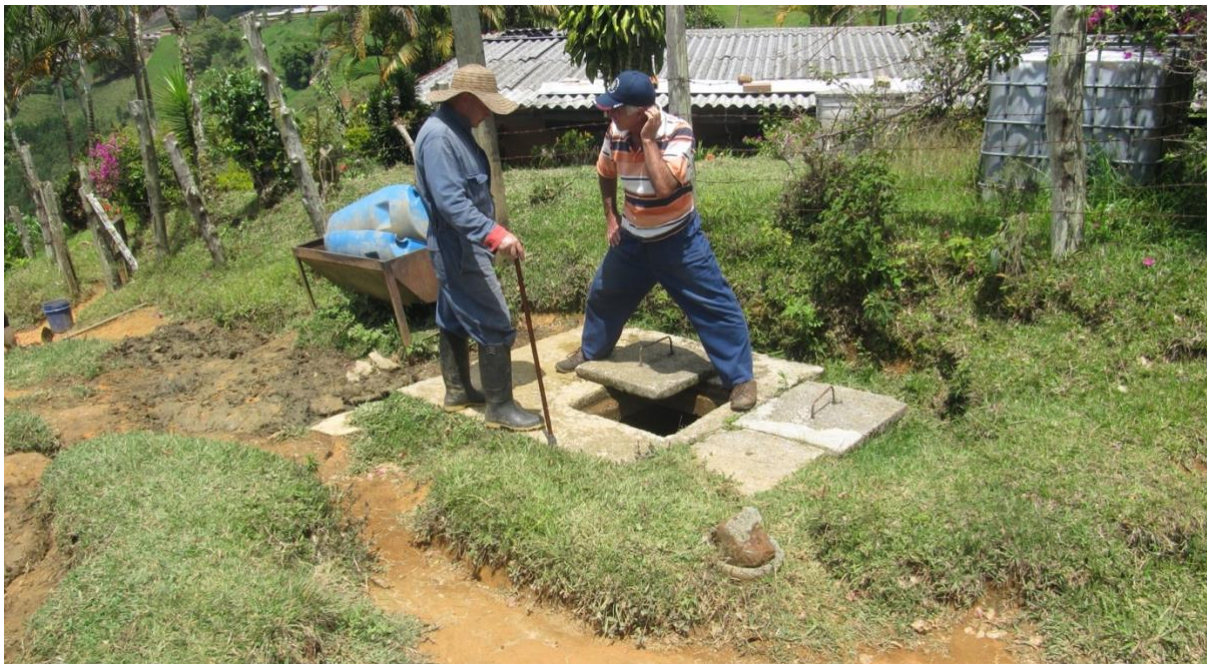
Canalisation d'alimentation en eau potable, Municipalité de Caldas, département de Antioquia, 2014 (source: Brendan Ecuyer)
