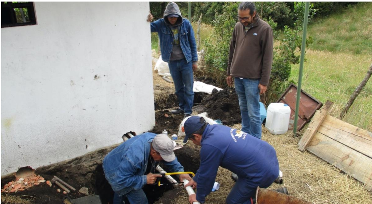
Changement de filtres et de conduites d'eau dans le cadre d'un convite organisé un dimanche à Los Mochuelos, dans la périphérie rurale de Bogotá en 2018 (source: Brendan Ecuyer)
